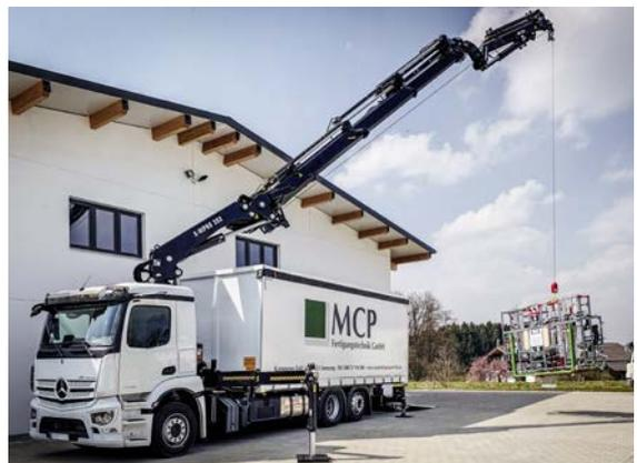
Die Entladung der RM<sup>2</sup> Modules erfolgt mit einem Kran, dabei werden die RM<sup>2</sup> Modules aus dem LKW herausgehoben und abgesetzt.
