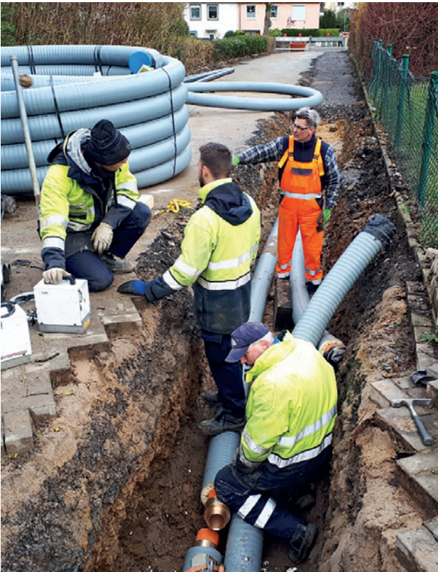
Bild 3. Verlegung der Hauptleitungen zwischen der Realschule und dem Neubauwohnquartier in Velbert
