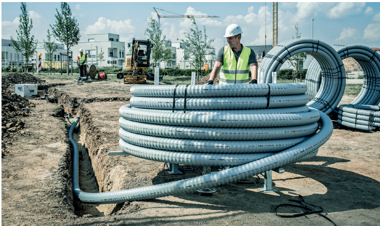
Zukunftsweisende Wärmeversorgung mit Nahwärme durch den Einsatz von flexiblen vorgedämmten PE-Xa-Rohrsystemen
