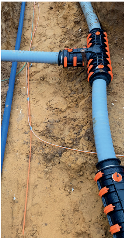
Bild 4. Verlegung von Trinkwasser-, Nahwärme- und Glasfaserinfrastruktur Quelle: Stadtwerke Wesel
