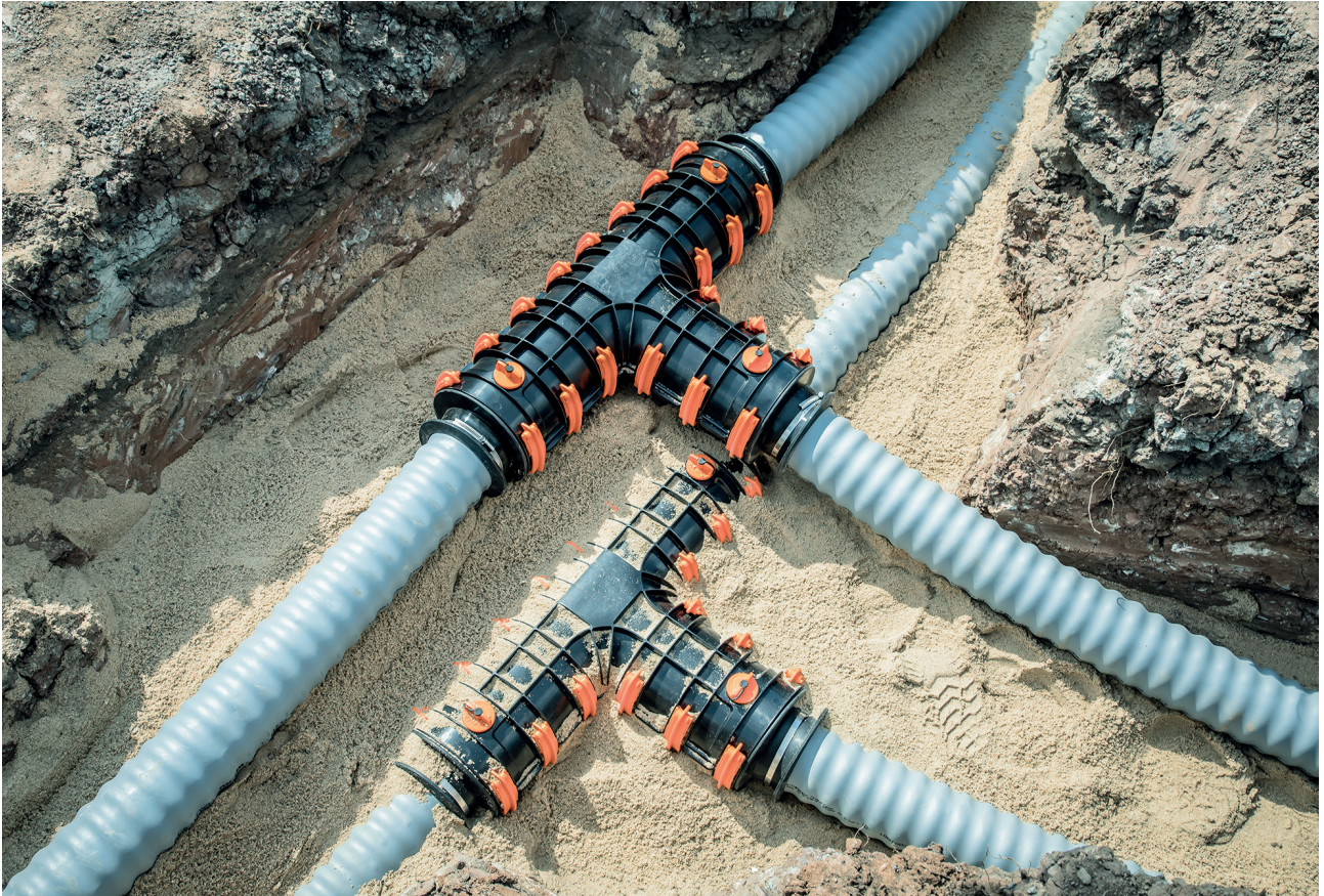
Bild 4. Verlegung von PMR-Einzelleitungen im Stufengraben zur Herstellung von Hausanschlüssen ohne Sonderformteile
