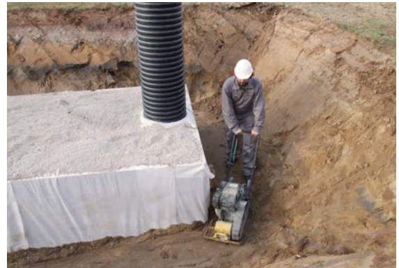
Verdichten des Arbeitsraums
