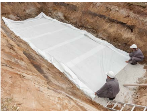
Baugrube mit RAUMAT Geotextilfilter
