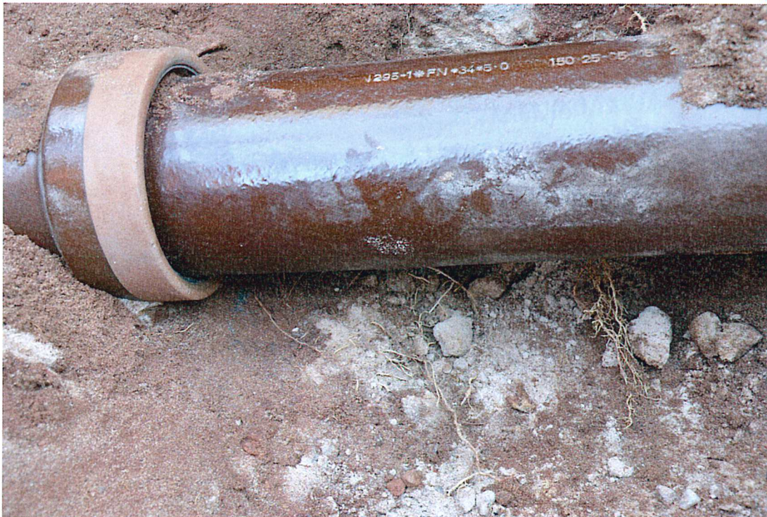
Abb.9 b: Zustand nach Aufgrabung Steinzeugleitung (Position der Muffe 3,3 m)
