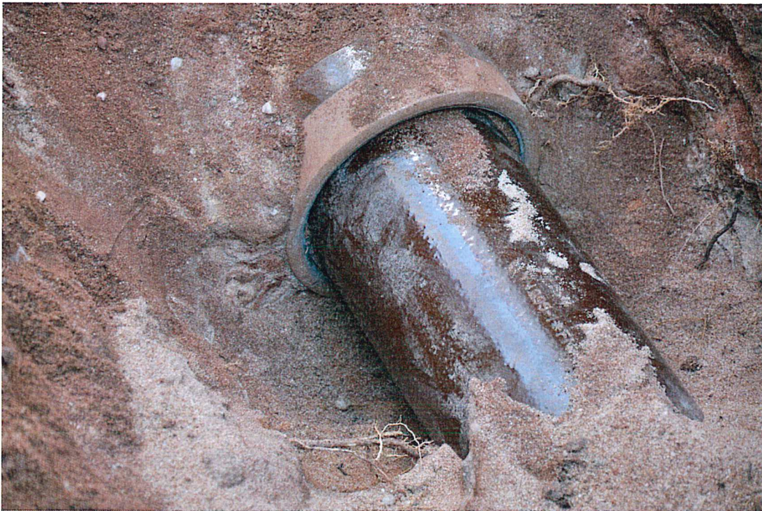
Abb.9 a: Zustand nach Aufgrabung Steinzeugleitung (Position der Muffe 3,3 m)
