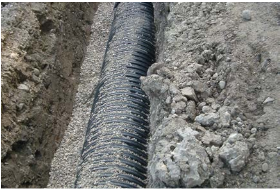
Fig. 07-3 Tubo RAUPIPEX na vala
